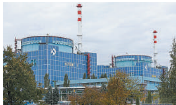
Рис. 42.9. Хмельницька АЕС: 2 атомні енергоблоки потужністю 1000 МВт кожен
