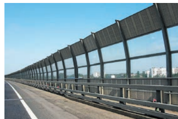
Рис. 6. Шумозахисні екрани, встановлені біля трас, зменшують рівень шуму в декілька разів
