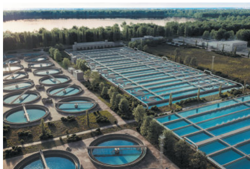
Станція для очищення стічних вод
