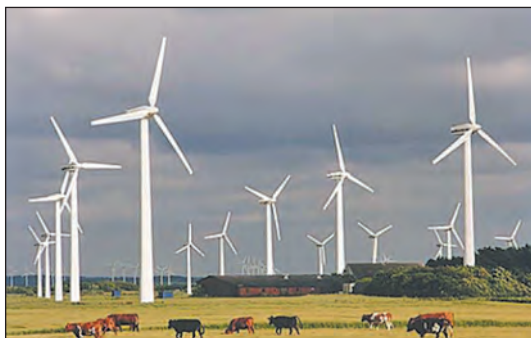
Мал. 5. Ботієвська ВЕС — найбільша вітрова електростанція України. Розташована поблизу села Приморський Посад (Запорізька обл.).
