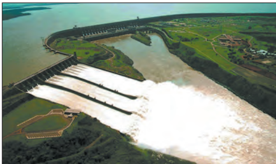
Мал. 1. «Ітайпу» (Бразилія) — одна з найпотужніших (14 МВт) ГЕС світу. Загальна довжина греблі складає понад 7 км, висота — 196 м.
