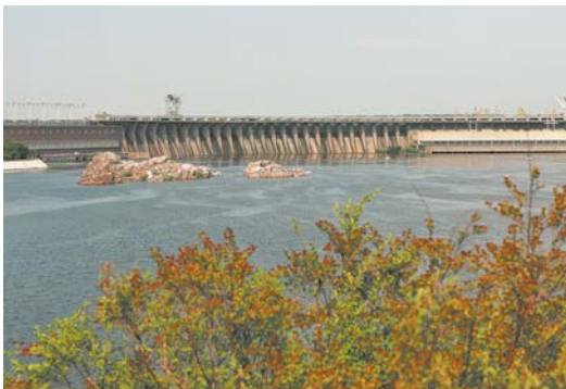
Мал. 43.3. Гребля Дніпровської гідроелектростанції
