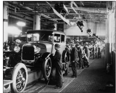
Складання автомобілів «Форд» на конвеєрі. Початок XX ст.
